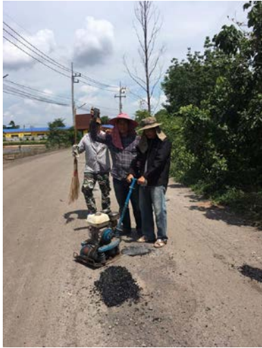
ซ่อมแซมถนนภายในพื้นที่ตำบลหัวหว้า
